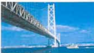
⑯明石海峡大橋
